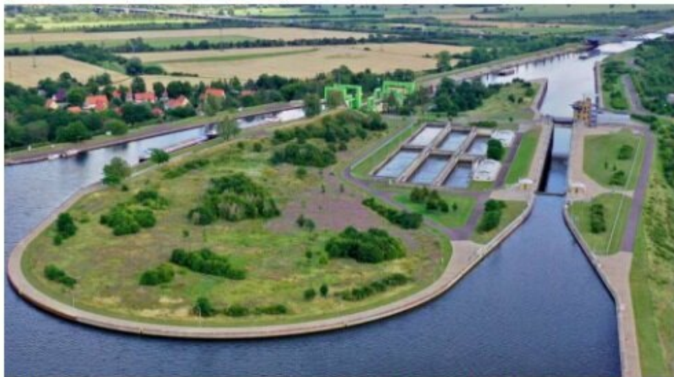
Ein Blick auf die Schleuseninsel Rothensee nördlich von Magdeburg: Hier soll eine Schleusenzentrale für Elbe, Havel und Saale entstehen.
