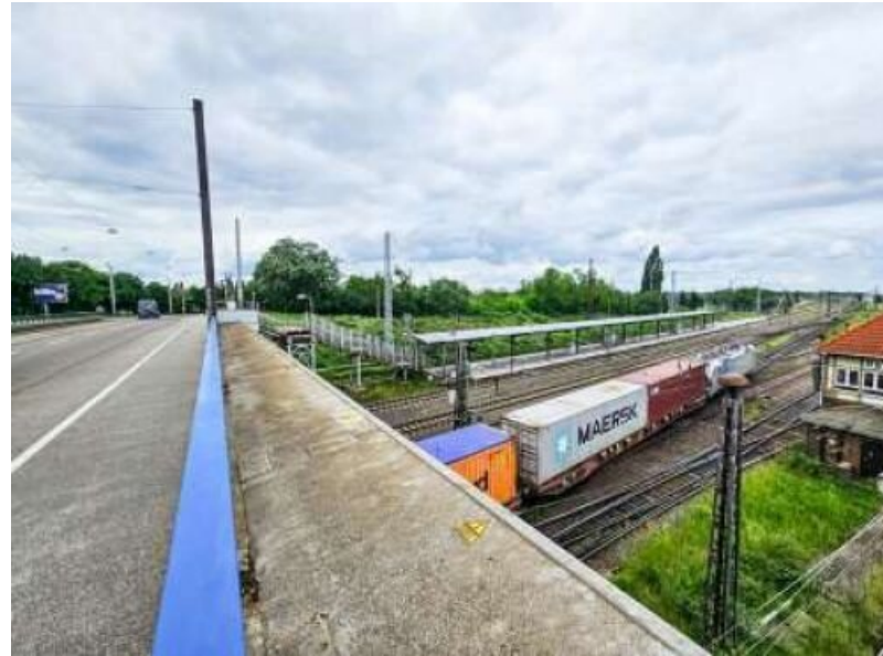
Unter der Pettenkoferbrücke befindet sich im Norden Magdeburgs ein Bahngelände. FOTO: MARTIN RIEB
