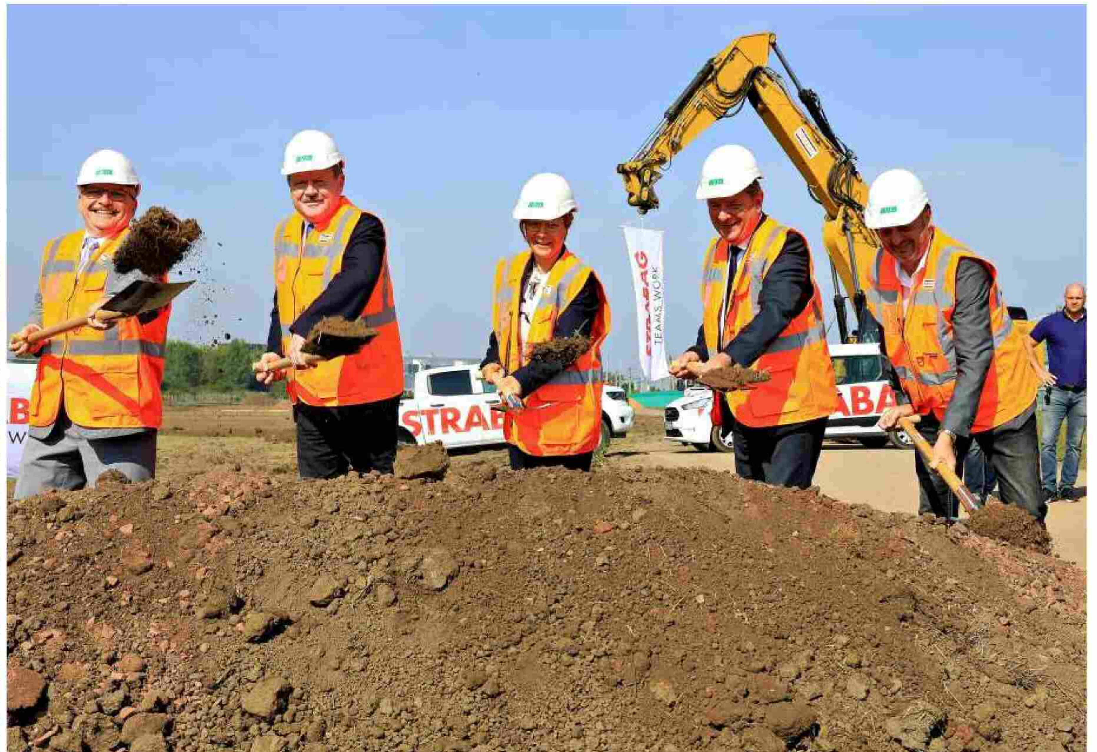
Spatenstich für ein Großprojekt: Der Neubau des Betriebshofs Nord beginnt.
