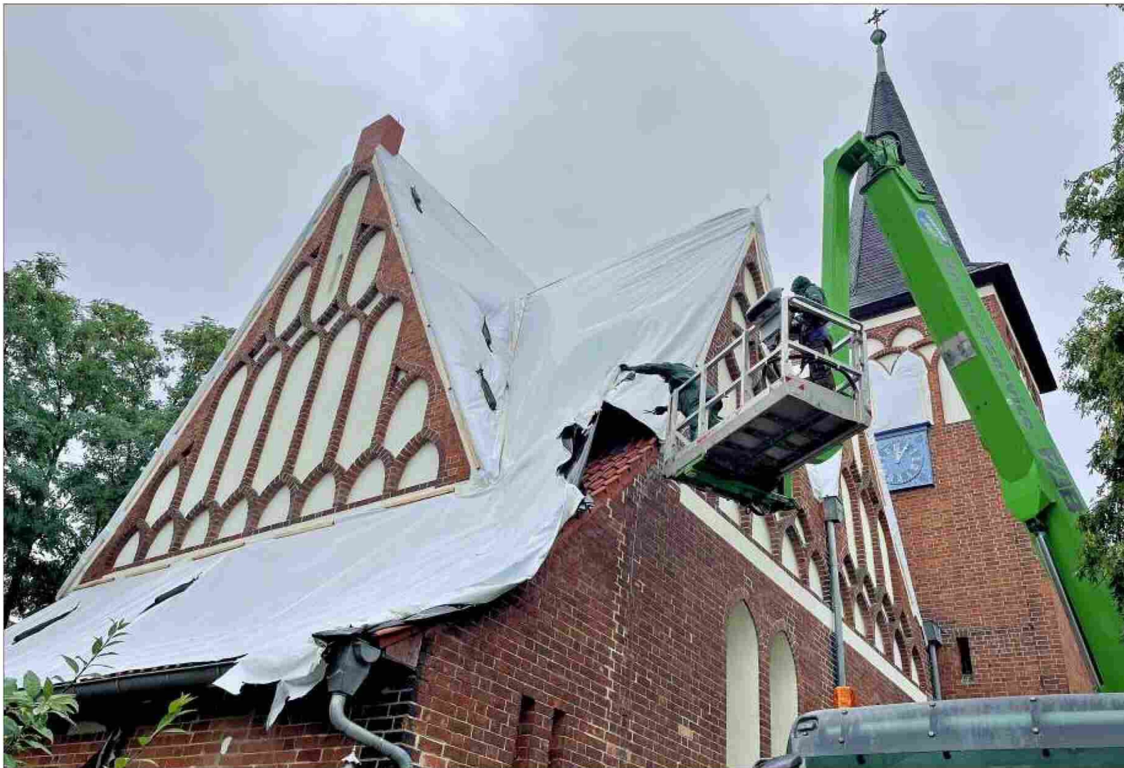
Für den Holzwurm war es gestern „fünf nach zwölf“: Nach der Schädlingsbekämpfung wurde die Reformationskirche Rothensee gestern wieder ausgepackt. Mehr als drei Tage lang war das Gotteshaus im Inneren mit einem Gas behandelt worden, um dem Holzwurm den Garaus zu machen.
