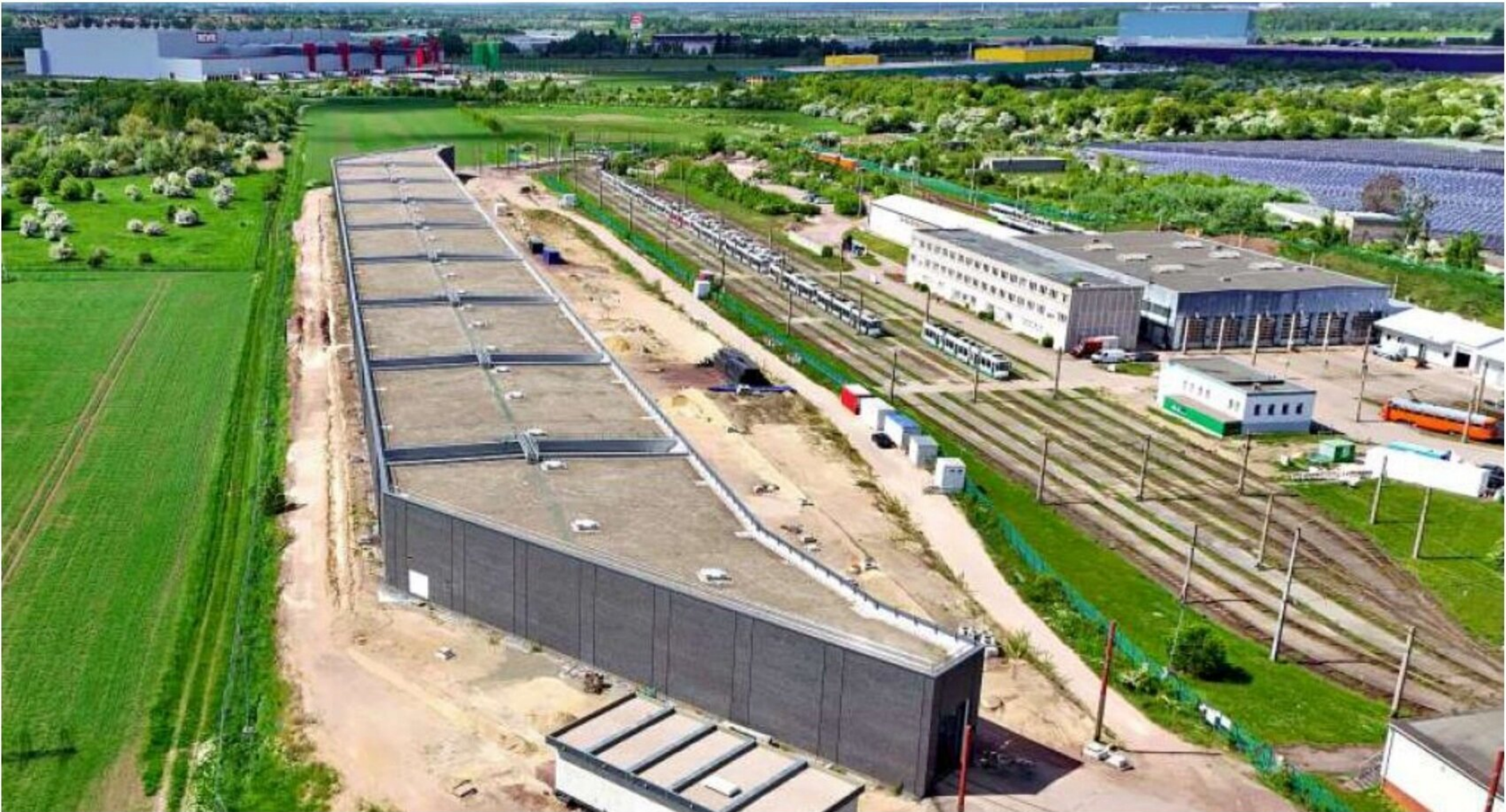
Die neue Abstellhalle der Magdeburger Verkehrsbetriebe (MVB) am Betriebshof Nord.
