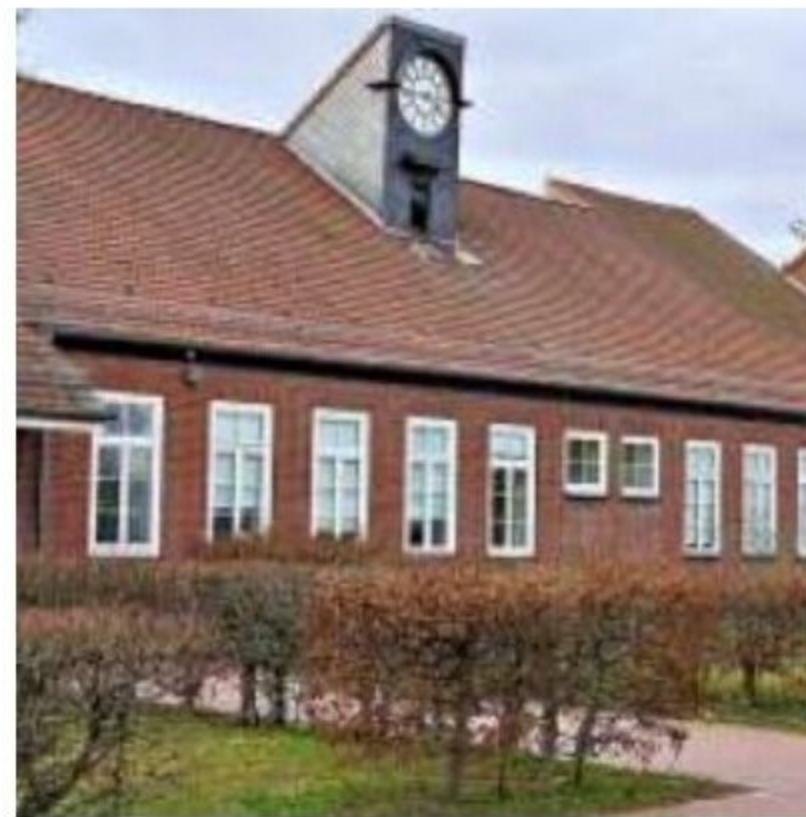
Die Grundschule in Rothensee muss nicht schließen.
