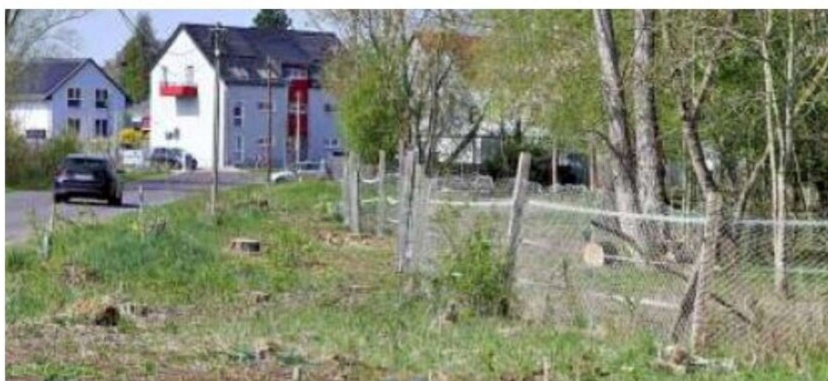
Für den Bau des Radweges ist bereits Baufreiheit geschaffen worden: Sträucher wurden entfernt und der Zaun der Pferdekoppel versetzt. FOTOS: SEBASTIAN PÖTZSCH
