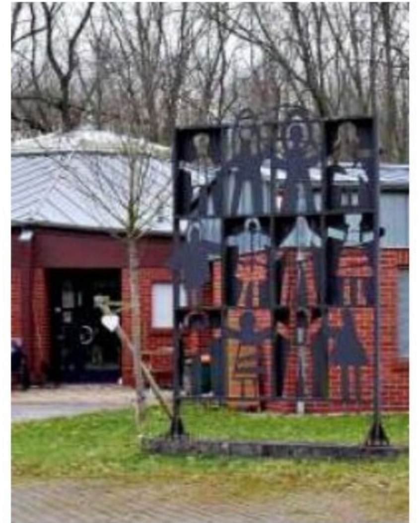
Blick auf das Jugendbegegnungszentrum am Barleber See. Der geplante Ausbau liegt auf Eis. FOTO: ULI LÜCKE
