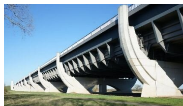
Die längste Kanalbrücke der Welt führt den Mittellandkanal über die Elbe. Foto: Gudrun Billowie
