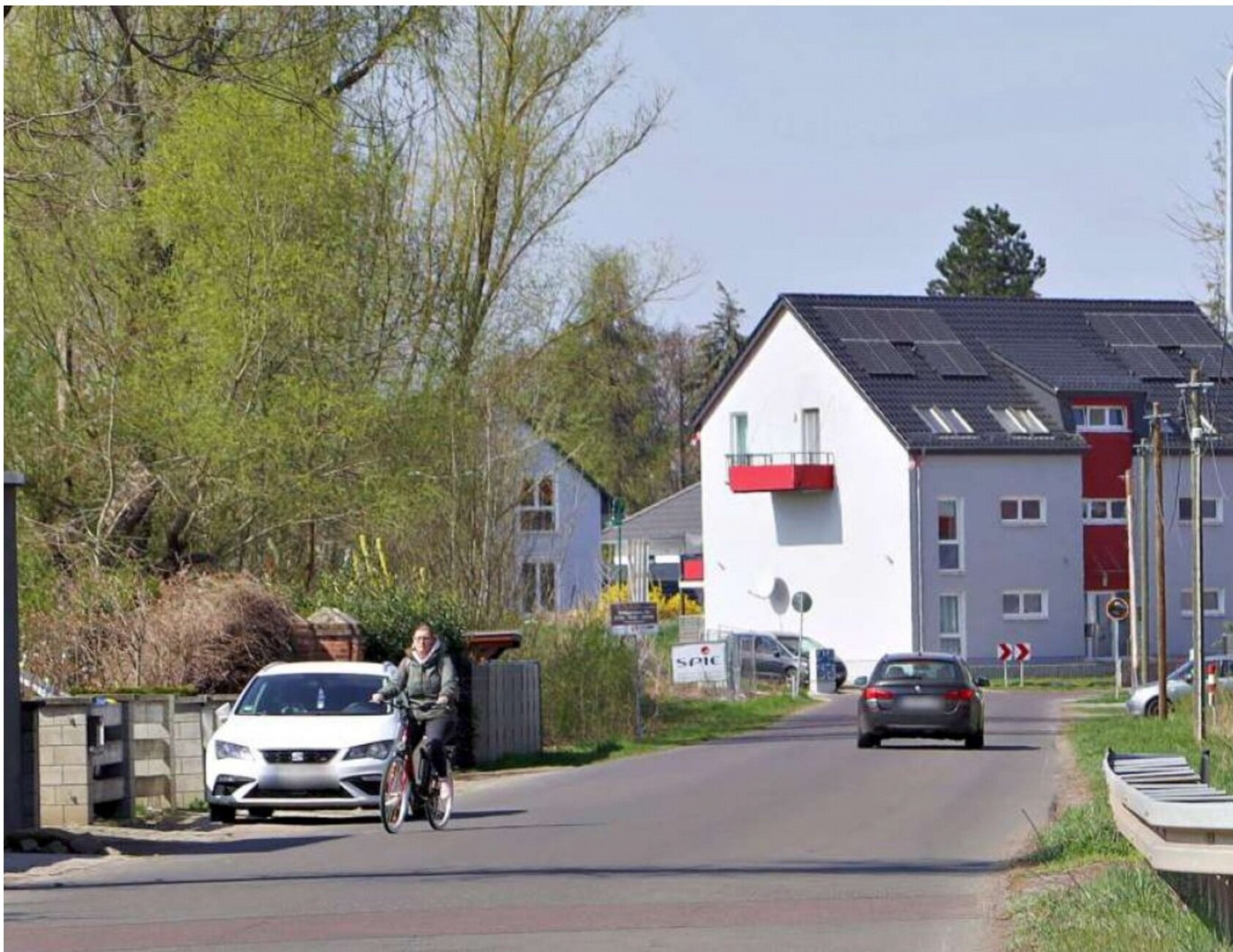
Damit Fahrradfahrer und Fußgänger nicht mehr die gefährliche Rothenseer Straße in Barleben nutzen müssen, wird nun der lang geforderte Radweg gebaut.
