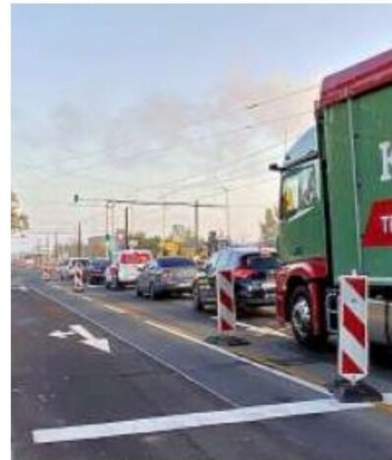
Die aktuellen Staus an der Baustelle auf dem August-Bebel-Damm sollen ab Montag Geschichte sein. FOTO: S. HARTER
