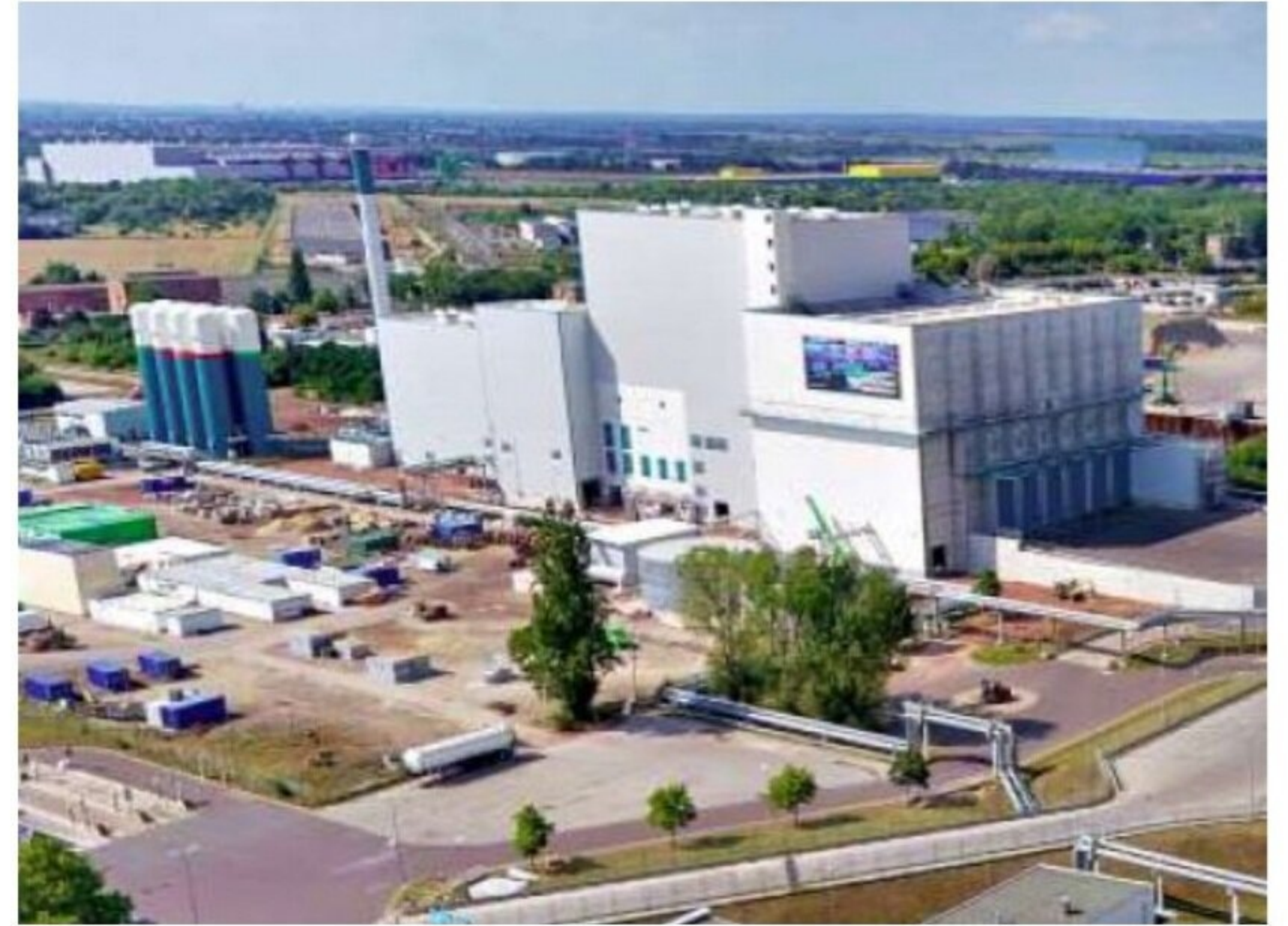
Der neue Block 3 im Müllheizkraftwerk Rothensee wurde im vergangenen Jahr in Betrieb genommen. Darin rumort es derzeit. FOTO: PETER GERCKE/MHKW
