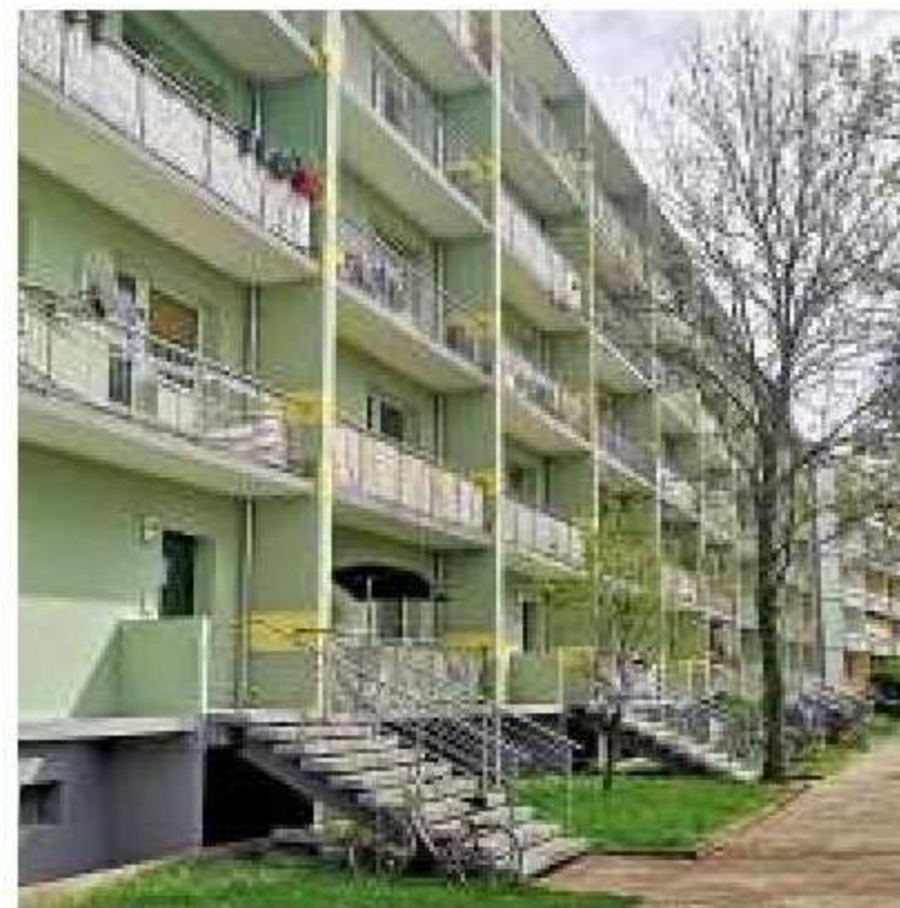
Die Wärme- und Wassersperre in der Forsthausstraße ist am Freitagabend aufgehoben worden. FOTO: KAROLIN AERTEL
