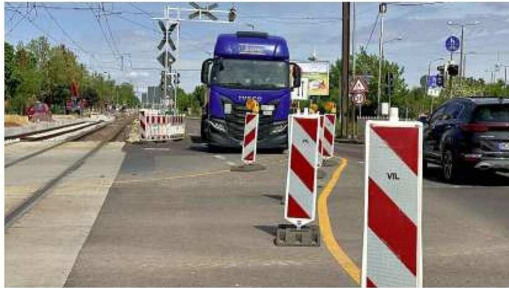
Nadelöhr August-Bebel-Damm: Aktuell wird der Verkehr schon von vier auf zwei Spuren gelenkt. Ab August soll es nur eine Spur geben. FOTO: SABINE LINDENAU
