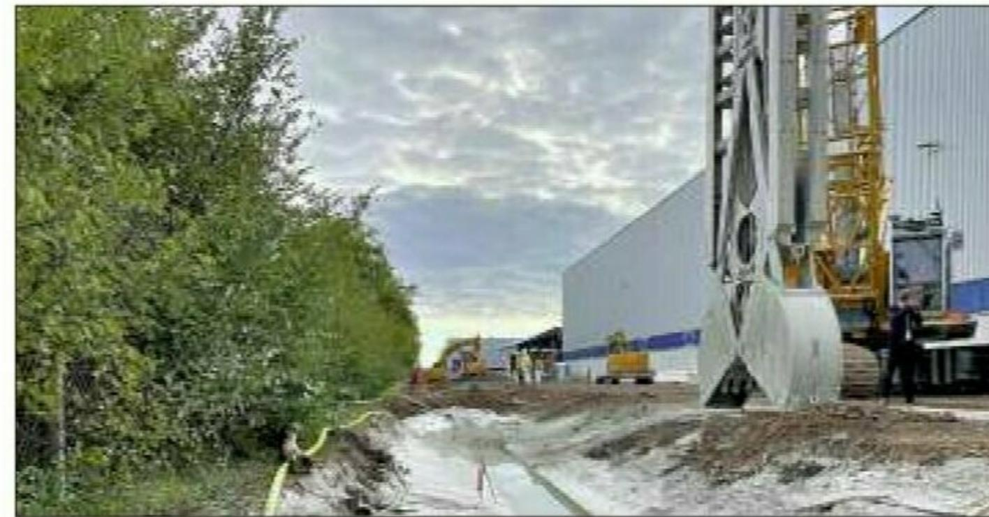
Auf dem Gelände der ehemaligen Großgaserei Magdeburg wird an dem Nordflügel eine Dichtwand errichtet.
