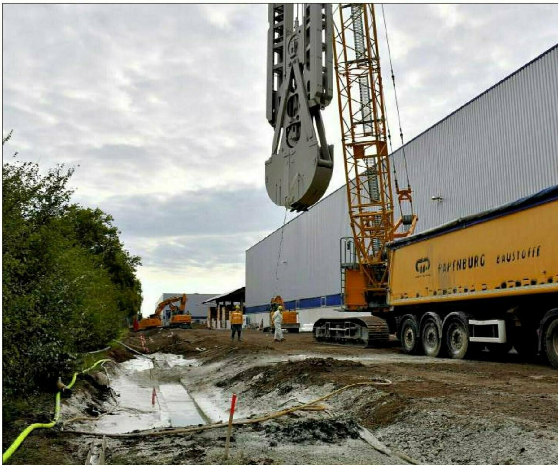
Mit der Hilfe eines zehn Tonnen schweren Schlitzwandgreifers wird auf dem Gelände der Nordlam GmbH eine Dichtwand über 25 Meter tief in den Boden gebracht. Sie soll verhindern, dass Schadstoffe mit dem Grundwasser in die Elbe gelangen.
