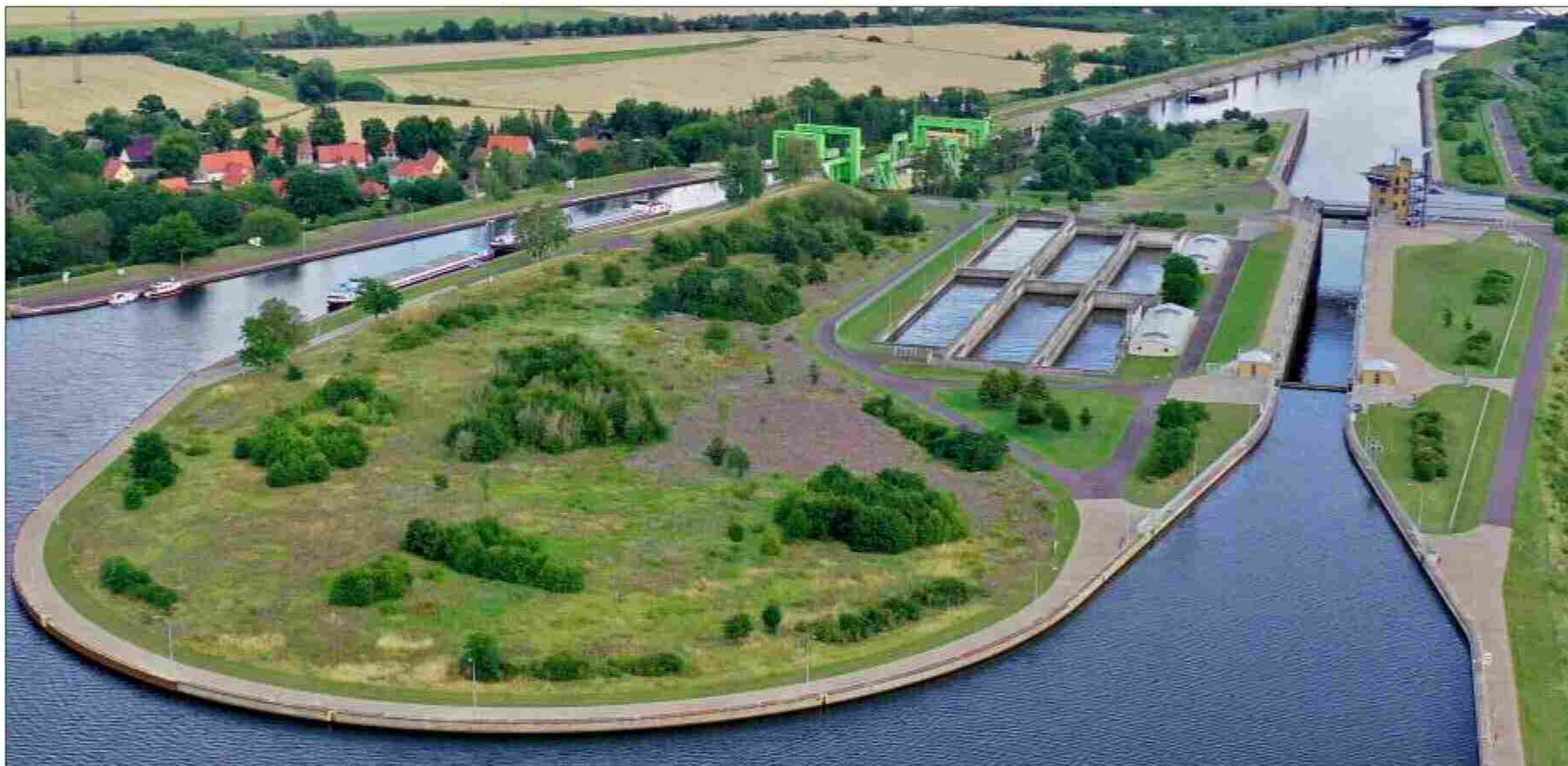
Die Schleuseninsel Rothensee mit Sparschleuse (rechts) und Schiffshebewerk. Auf der Freifläche im Vordergrund soll die Großleitzentrale entstehen.
