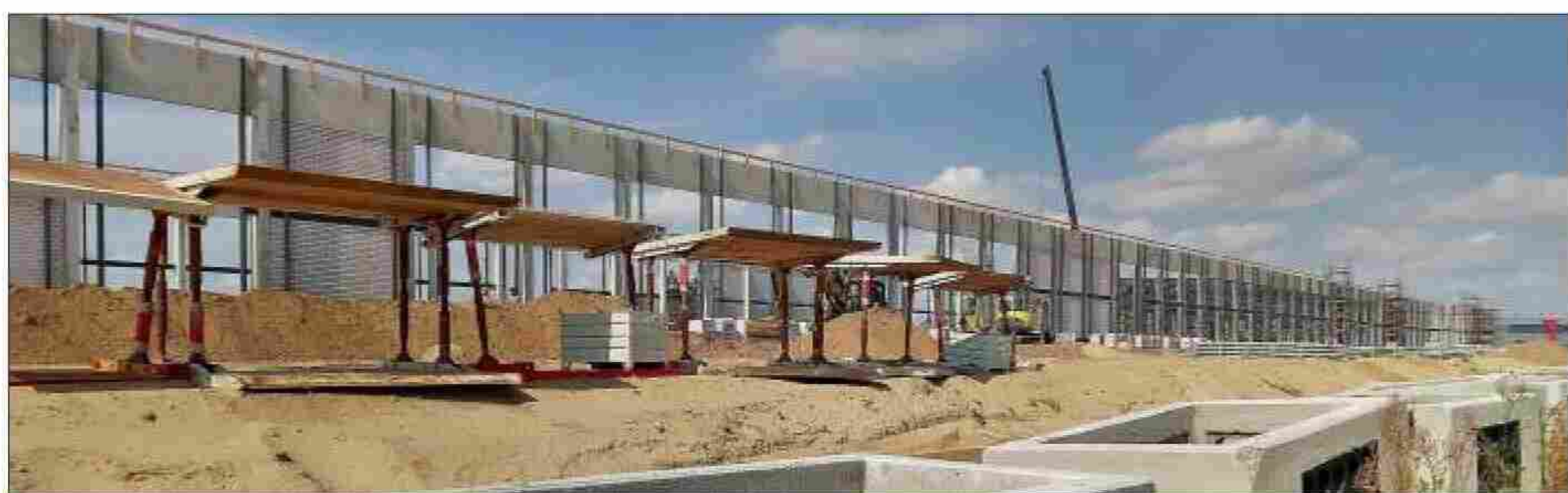
Am Betriebshof Nord wird zunächst die neue Abstellhalle gebaut.
