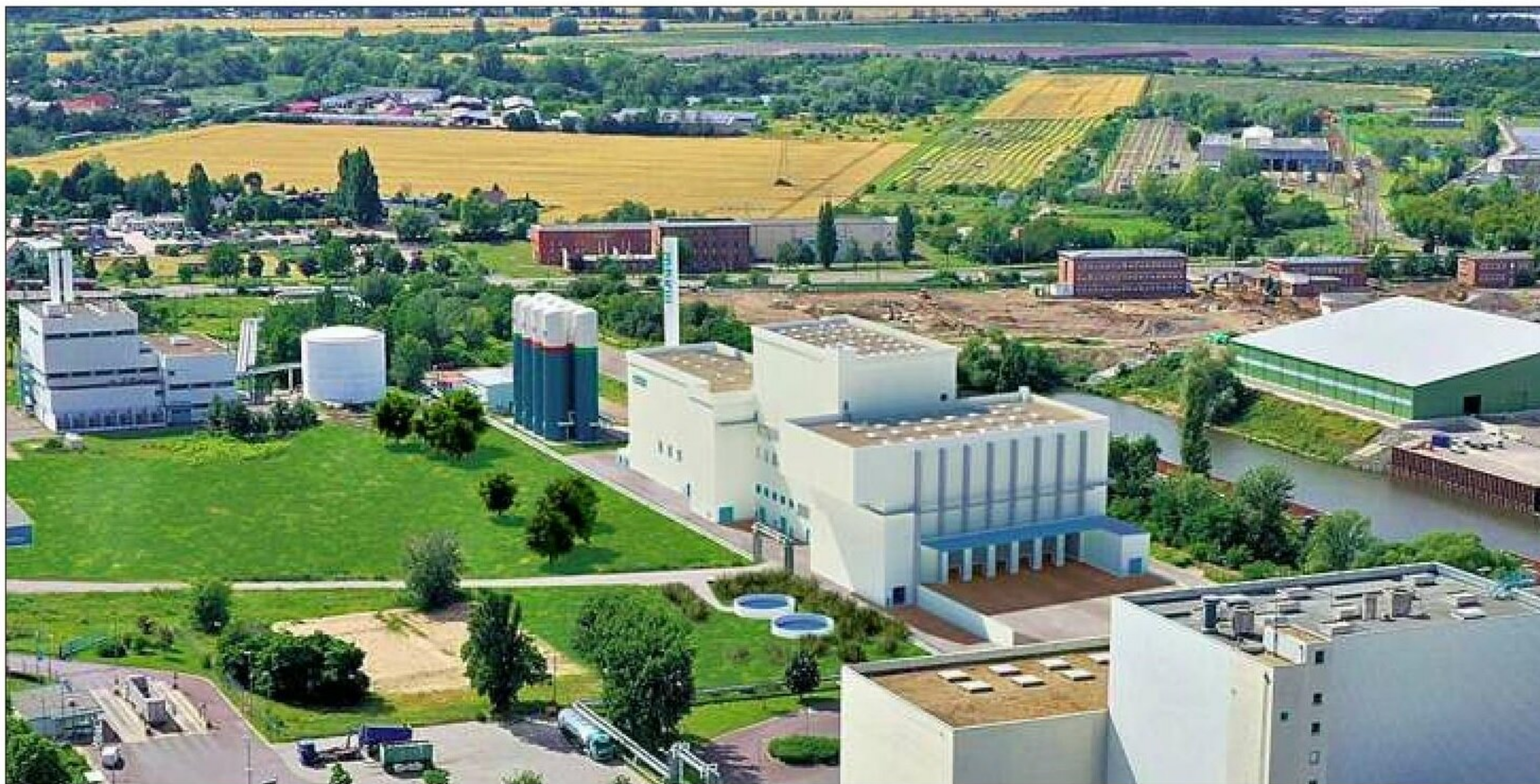
So soll die dritte Verbrennungsanlage am Müllheizkraftwerk Rothensee aussehen. Die Grundsteinlegung für den Block 3 wurde am Freitag gefeiert. Visualisierung: MHKW Rothensee
