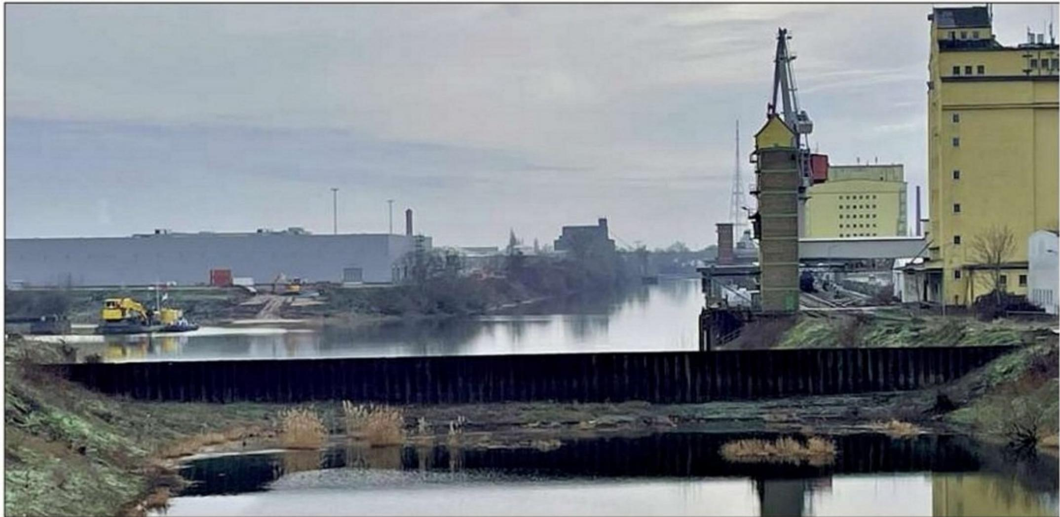
Auf Höhe der Steinkopffinsel ist der Industriehafen (im Foto oben) noch abgetrennt. Der alte Industriehafen soll reaktiviert, wasserstandunabhängig und an den Magdeburger Hafen angeschlossen werden. Dazu wird ein sogenannter Fangedamm errichtet, wofür bereits die Arbeiten begonnen haben (links). Der alte Absperrdamm (vorn) zum Zweigkanal kann dann abgerissen werden.
