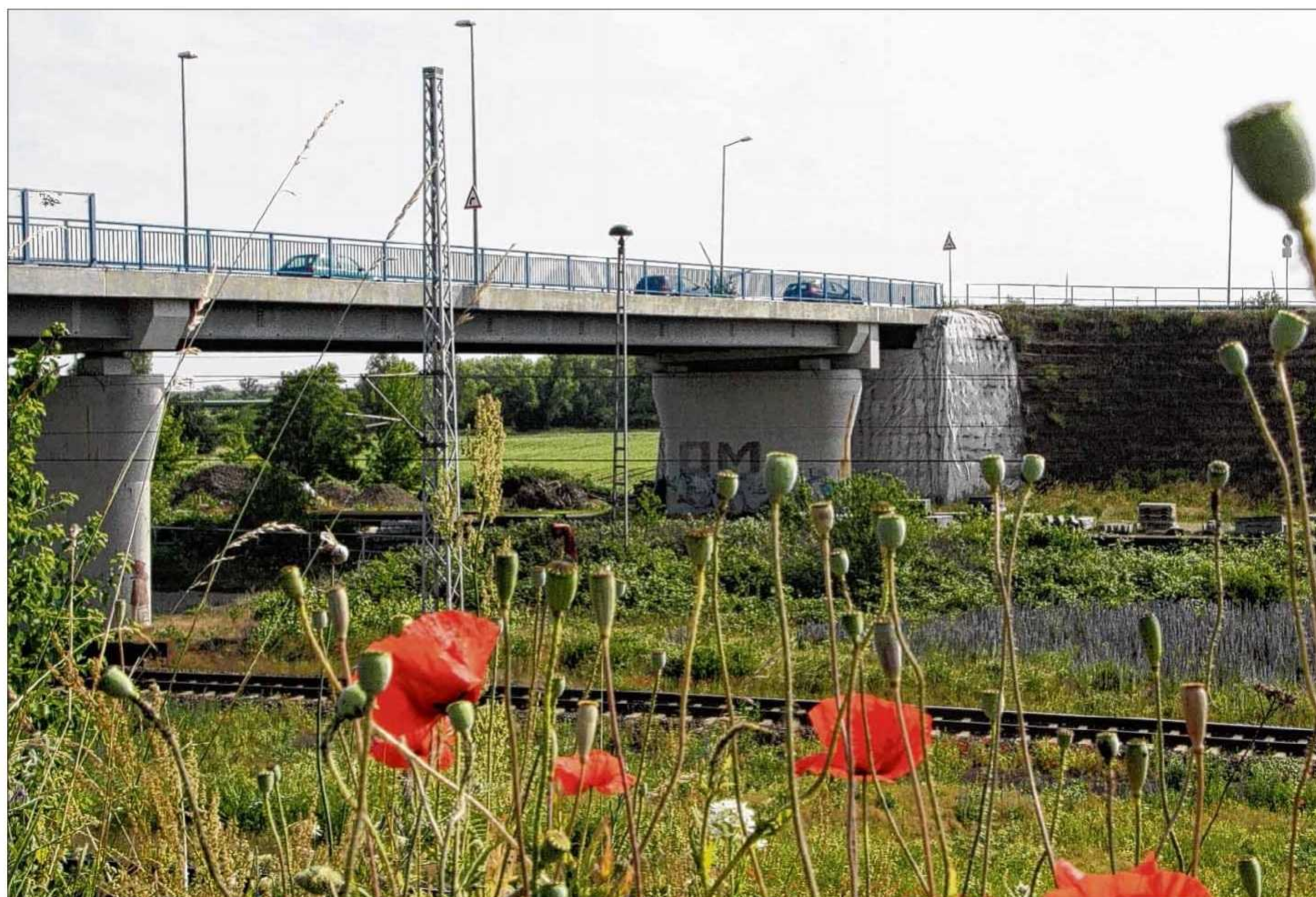
Blick auf die Brücke Oebisfelder Straße über die Anlagen der Deutschen Bahn. Sie war 2000/2001 als Provisorium errichtet worden und hat ihre eigentliche Lebensdauer längst überschritten. Nun soll ein Neubau her. Foto: Stefan Harter
