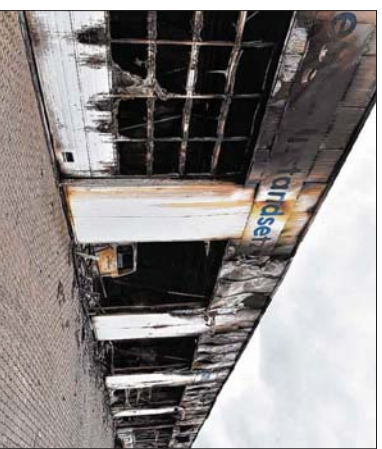
An der Fassade des Gebäudes sind die Schäden des Brandes deutlich zu erkennen.
