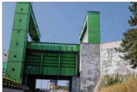
Blick auf das Schiffshebewerk. Auch die Betonmauern am sich anschließenden Kanal rechts im Bild müssen saniert werden.
