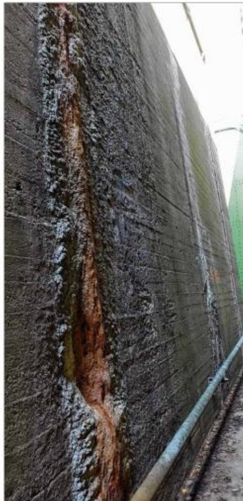
Über mehrere Meter zieht sich dieser Riss durch die Betonwand des Schiffshebewerks Magdeburg-Rothensee. Fotos (3): Martin Rieß
