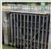
Das Stemmtor muss ebenfalls saniert werden.
