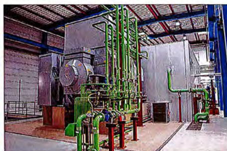
Das Turbinenhaus. Vorn ist der Generator (rund) zu sehen, der den Strom erzeugt. Er ist mit der 33,6-MW-Dampfturbine (verkleidet) verbunden.
