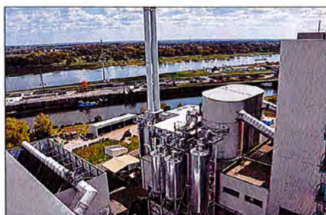
Die Rauchgasreinigungsanlage. Dort werden die schadstoffbelasteten Abgase aus den Verbrennungsöfen gereinigt, bevor sie ins Freie abgegeben werden.
