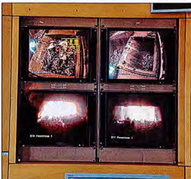
Über Monitore kann das Innere der Verbrennungsöfen, in denen eine Temperatur von rund 850 Grad herrscht, kontrolliert werden.
