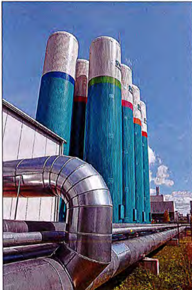
Seit Anfang dieses Jahres verfügen die SWM und das MHKW für die Energiespeicherung über diese acht Wärmespeicher, in denen heißes Wasser für das Fernwärmenetz so lange gespeichert werden kann, bis es gebraucht wird.
